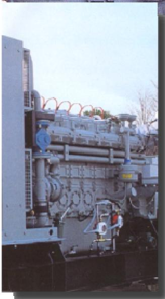
In una centrale di cogenerazione il calore di scarico della macchina per la produzione di energia elettrica ha livelli termici elevati e di conseguenza può essere utilizzato direttamente, come i fumi per l'essiccamento, oppure a ciclo combinato, per produrre una ulteriore quota di energia elettrica. Non ci sono dubbi sui vantaggi, in termini di rendimento energetico, che la cogenerazione ha rispetto alla produzione separata di energia elettrica o termica.
